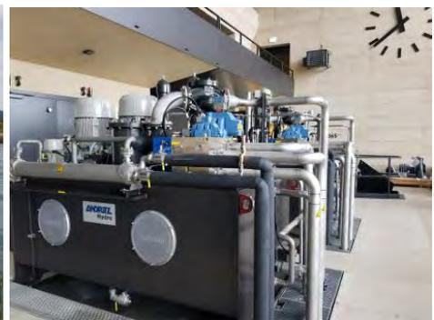
Hydraulische Steuerung der Turbinen
