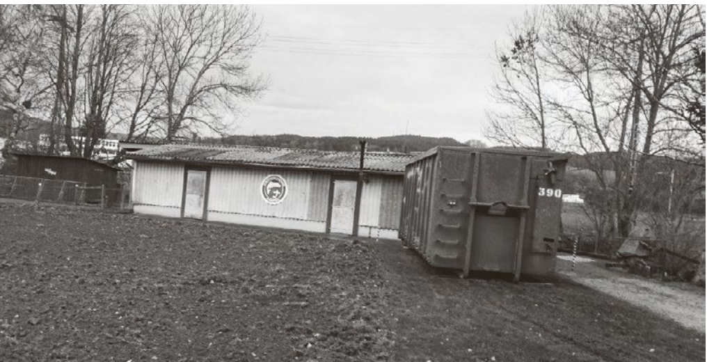
Baubeginn mit absetzen der Mulde
