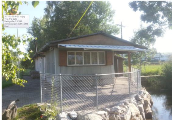
Finales Werk mit neuer Bodenplatte, Stützmauer und Blocksteinverbauung
